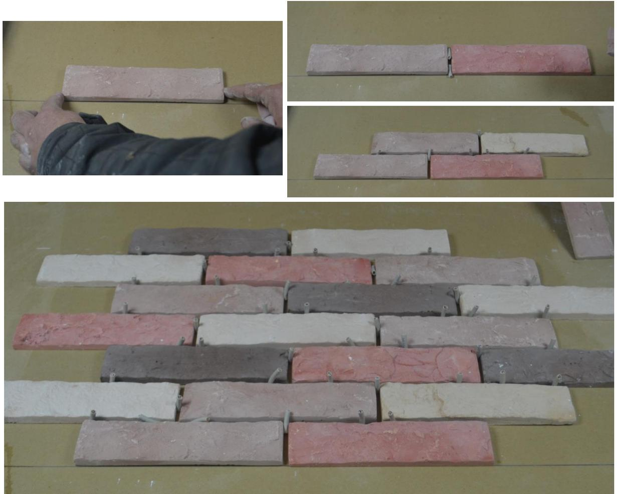
После предварительного схватывания клеевой смеси (30-120 мин в зависимости от основания) удаляем кусочки кабеля. Окончательное схватывание клеевого раствора происходит в сроки, установленные их производителями.
