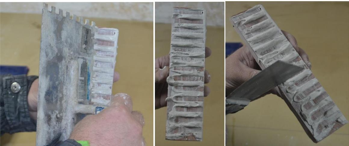
Укладываем плитки декоративного камня начиная с углов внешних или внутренних. Слегка прижмите плитку к стене и «подвигайте» ее из стороны в сторону, чтобы обеспечить наилучшее примыкание к поверхности. Выполняем расшивку с помощью заготовленных ранее кусочков кабеля:
